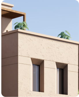
4 نوافذ ذات أحجام متنوعة، وجميعها مستطيلة الشكل، وغائرة، وذات حواف مشطوفة من جهة واحدة.
